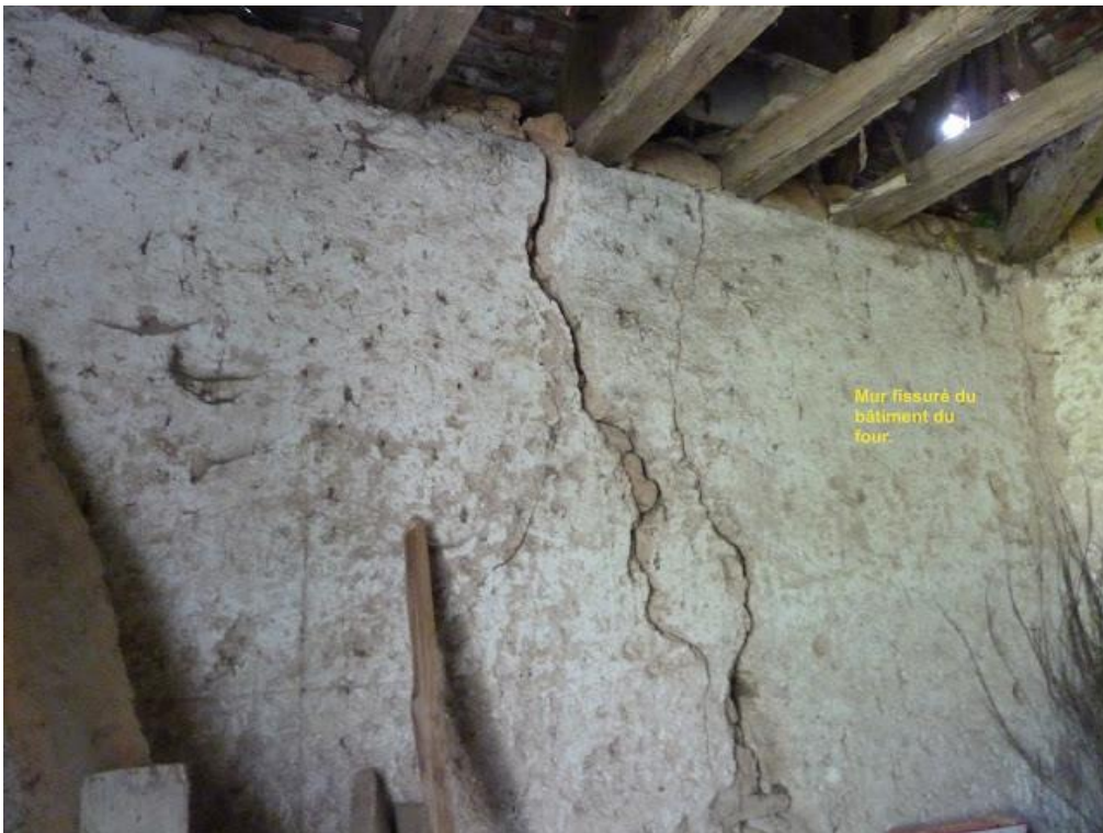
Mur en terre de l'abri du four avec fissures sans doute antérieures à la confection de la charpente.
