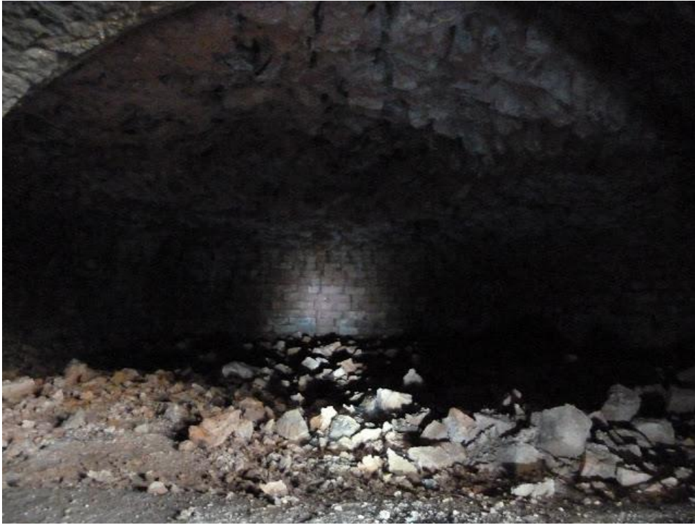
Intérieur du four où l'argile rubéfiée tombe en morceaux.
