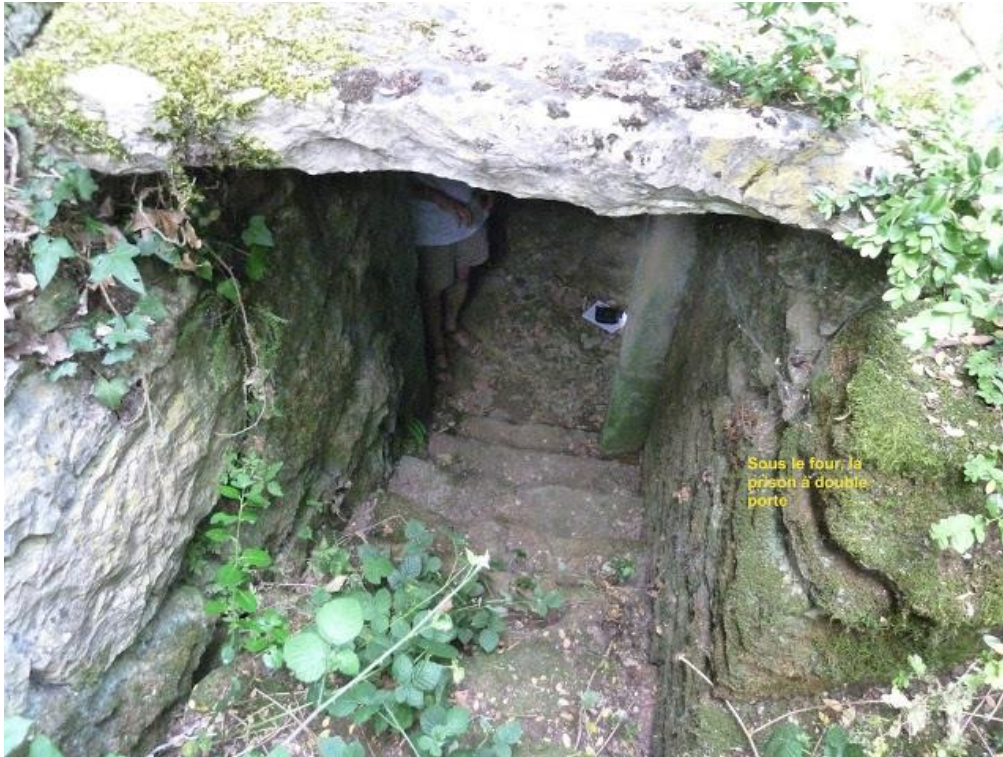
Entrée du le cellier ou "la prison" sous le four à pain
