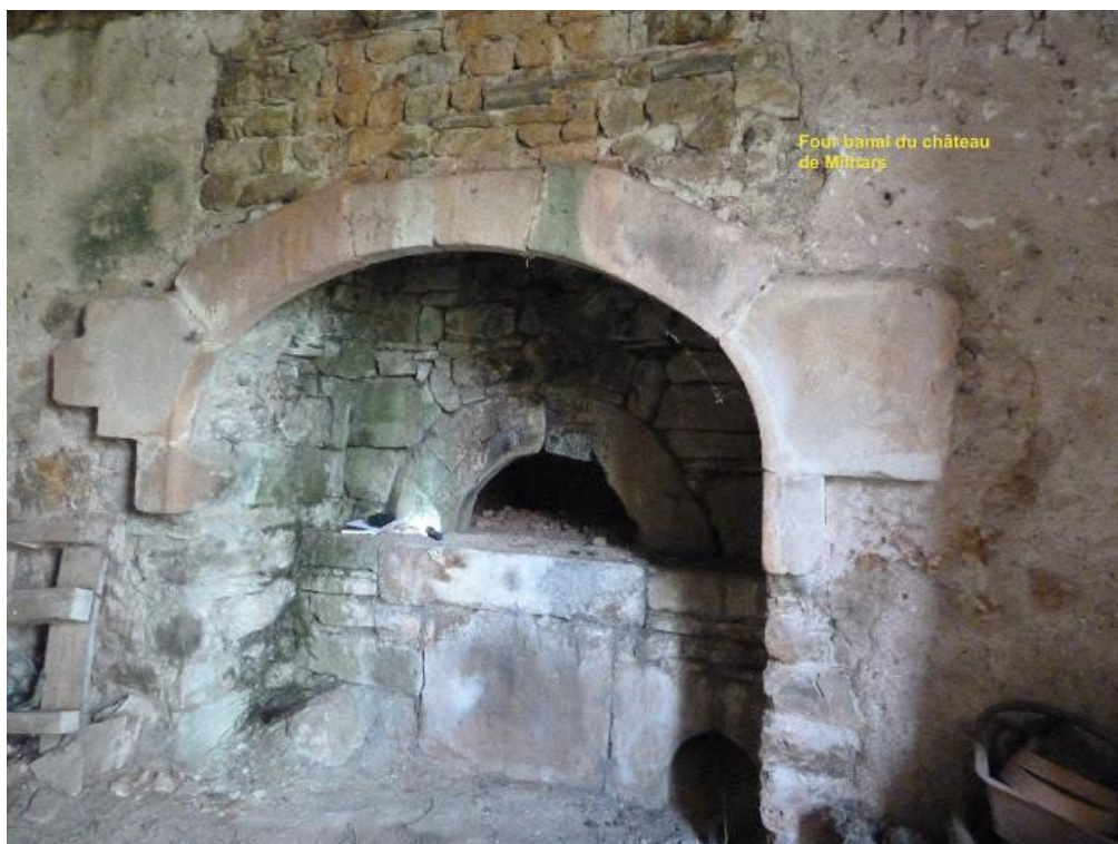
Le four (grès + calcaire) est protégé par un toit voûté. À l'intérieur, la structure est tapissée d'une couche épaisse d'argile.
