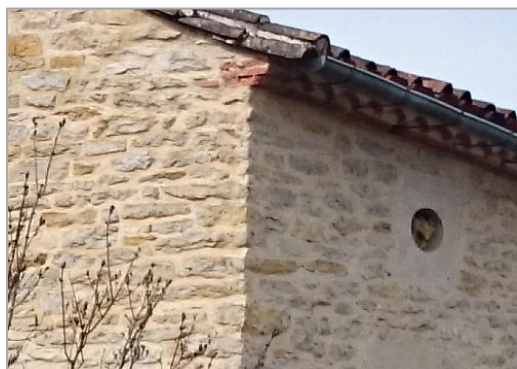
ILLUSTRATION 22 : APPAREIL DE CONSTRUCTION D'HABITATION REALISE A BASE DE PIERRES CALCAIRE – PHOTO : URBA2D, 2016
