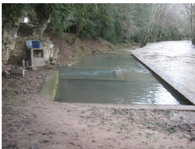
Source du Lavoir immergée pendant une crue du Cérou (13/02/2007)
