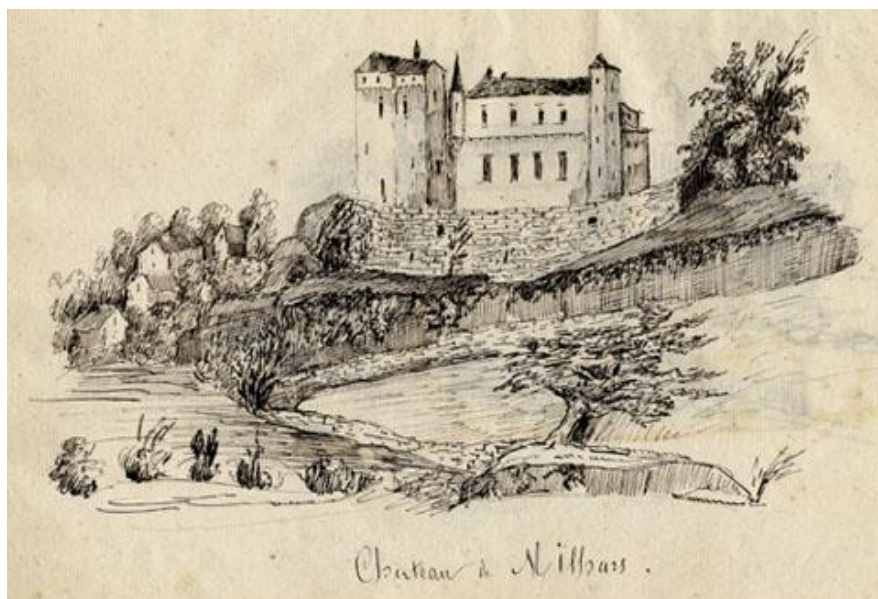
Façade Est du château qui s'est écroulée.
